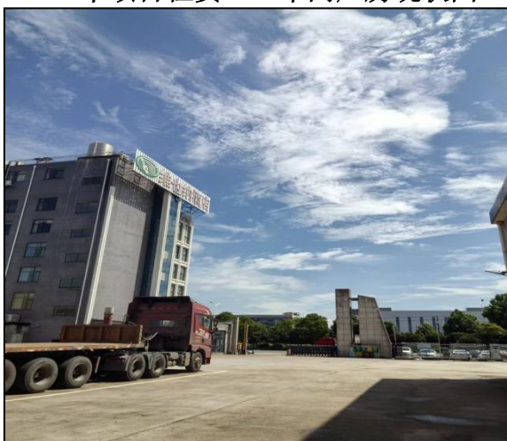
项目厂区周边环境现状图
