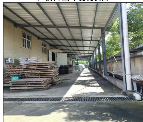
厂房侧边出入口现状图
