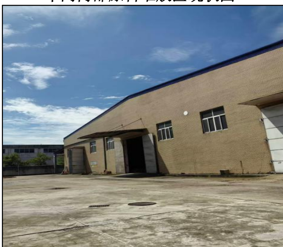
本项目租赁 101 车间厂房现状图
